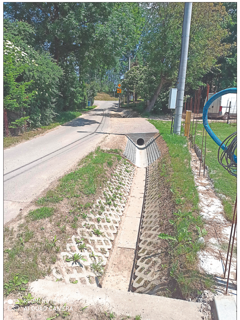
Zmodernizowany rów przy ul. Zakole.
