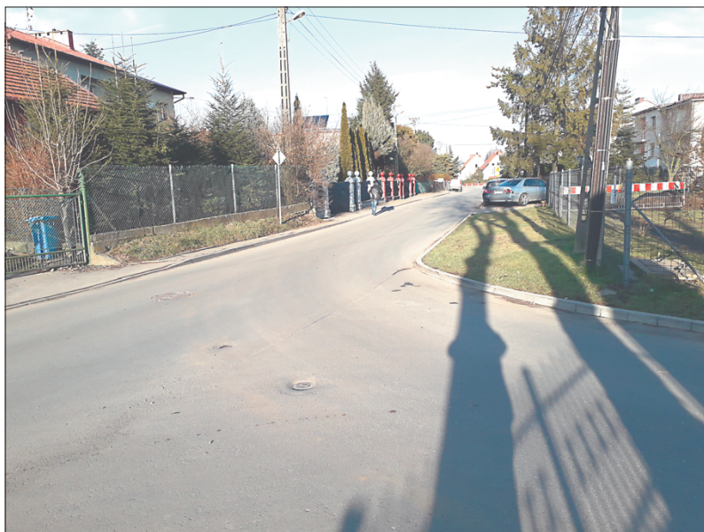
Ulica Grębałowska po remoncie.
