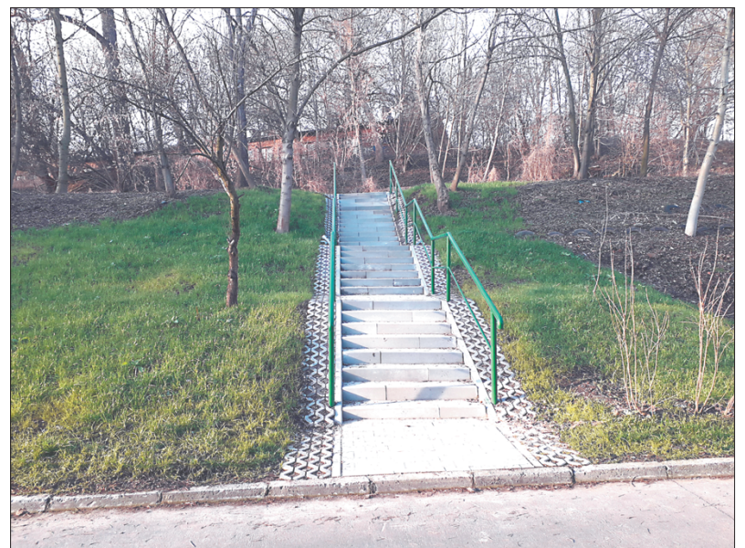
Schody (ul. Kownackiej, ul. Petöfiego) po remoncie.
