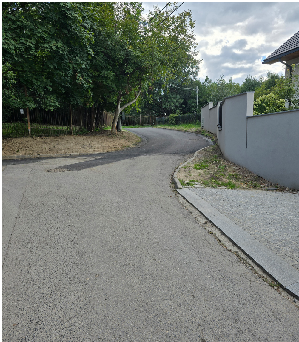
ul. Geodetów ciąg pieszo-jezdny
