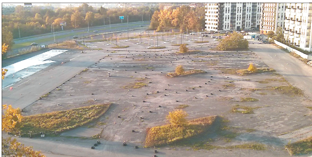
Początkowy etap budowy parku.
