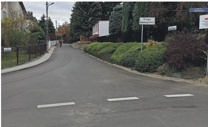
Fot. ul. Twaroga, remont drogi.
