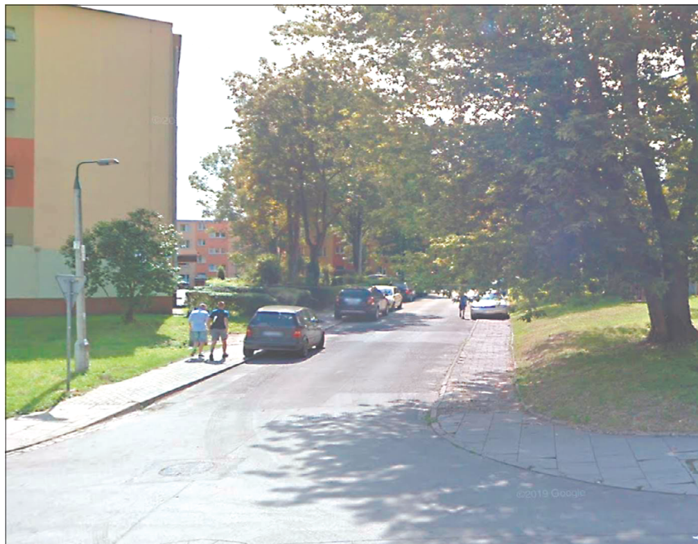
Na Stoku 48 – przed remontem chodnika.
