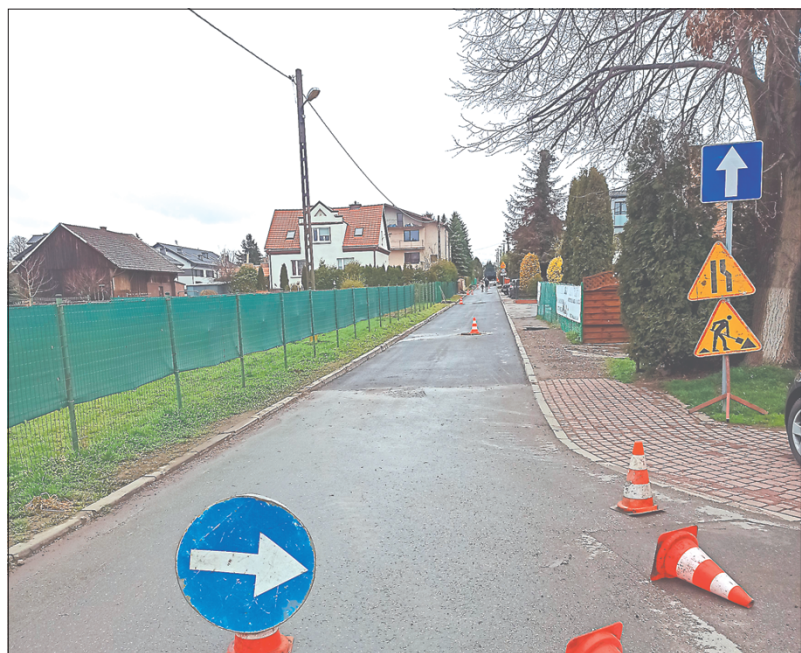
Ul. Grębałowska – nakładka wykonana w ramach VII edycji BO.
