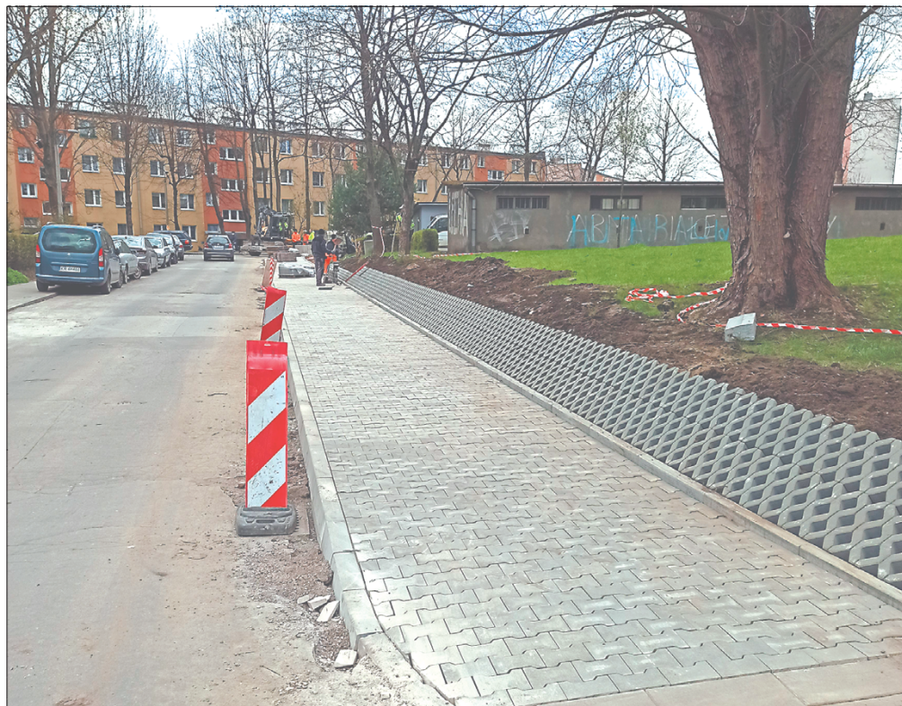
Na Stoku 48 – kwiecień 2021 r., remont zbliża się ku końcowi.
