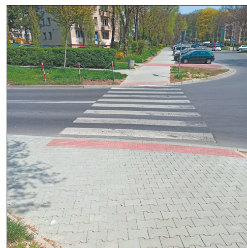
Przejście dla pieszych: ul. Jagiełły/ul. Poległych w Krzesławicach.
