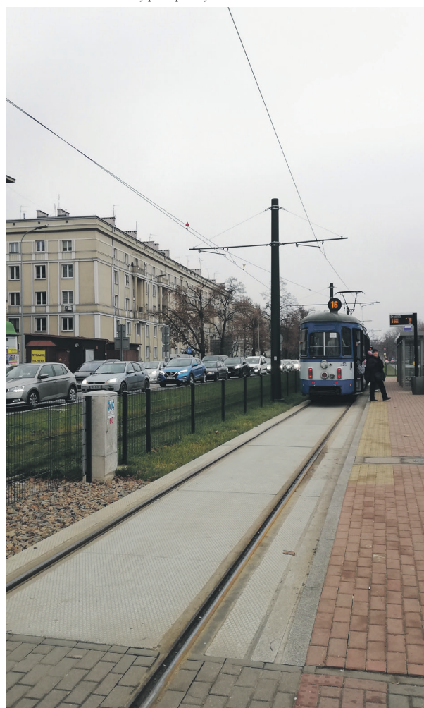
Fot. nowe torowisko ul. Ptaszyckiego
