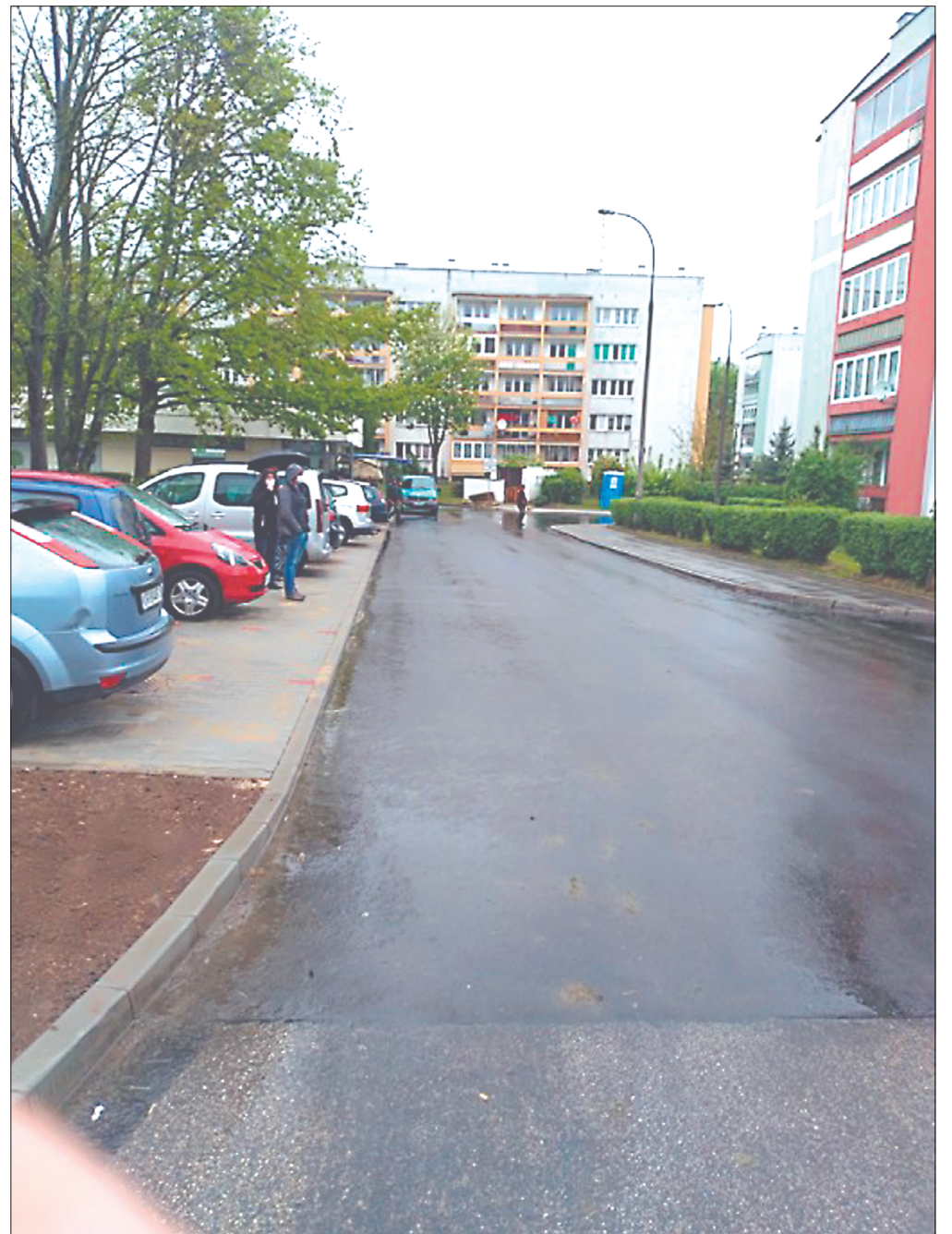
Wyremontowana ulica Monda wraz z chodnikiem.
