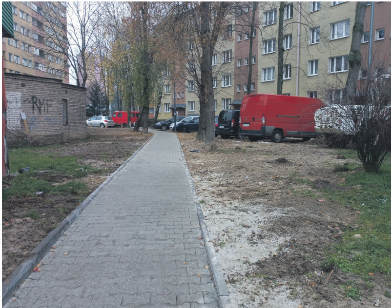
Fot.: remont chodnika, Os. Albertyńskie
