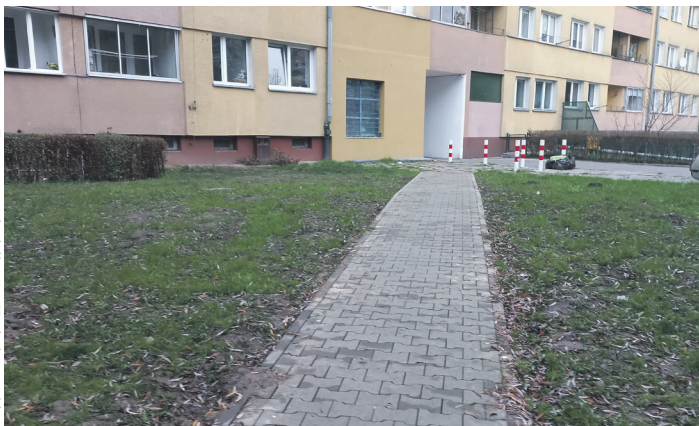
Fot.: remont chodnika, Os. Kazimierzowskie
