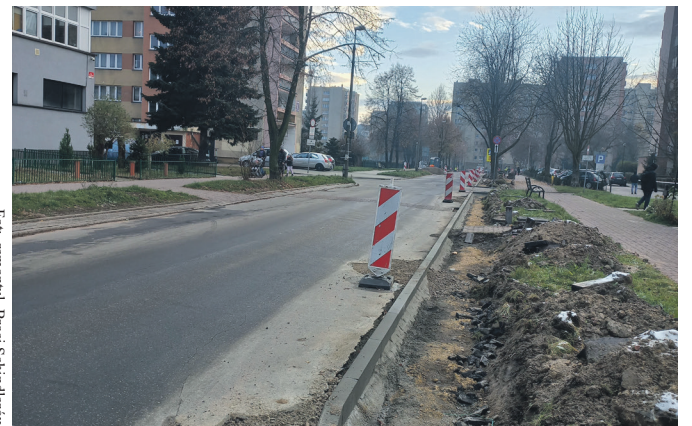
Fot.: remont ul. Braci Schindlerów
