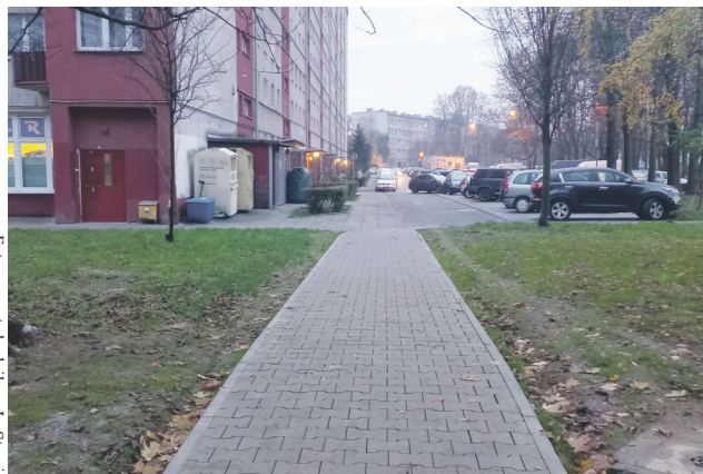
Fot.: remont chodnika, ul. Strusia
