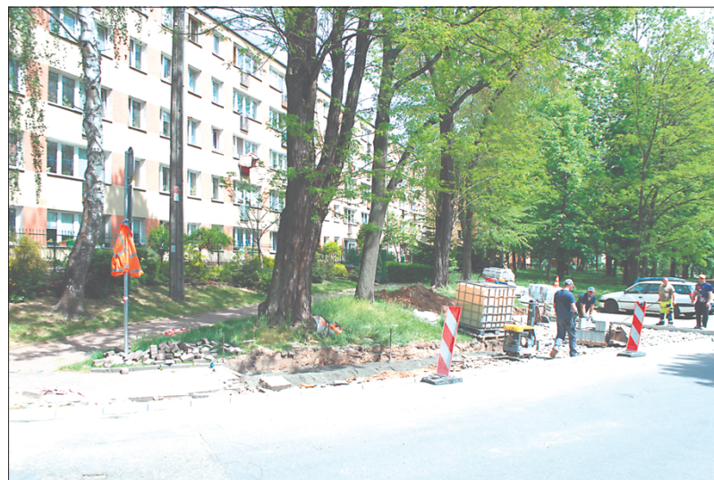
Trwają prace remontowe przy ulicy Andegaweńskiej. Fot. Zygmunt Bińczycki
