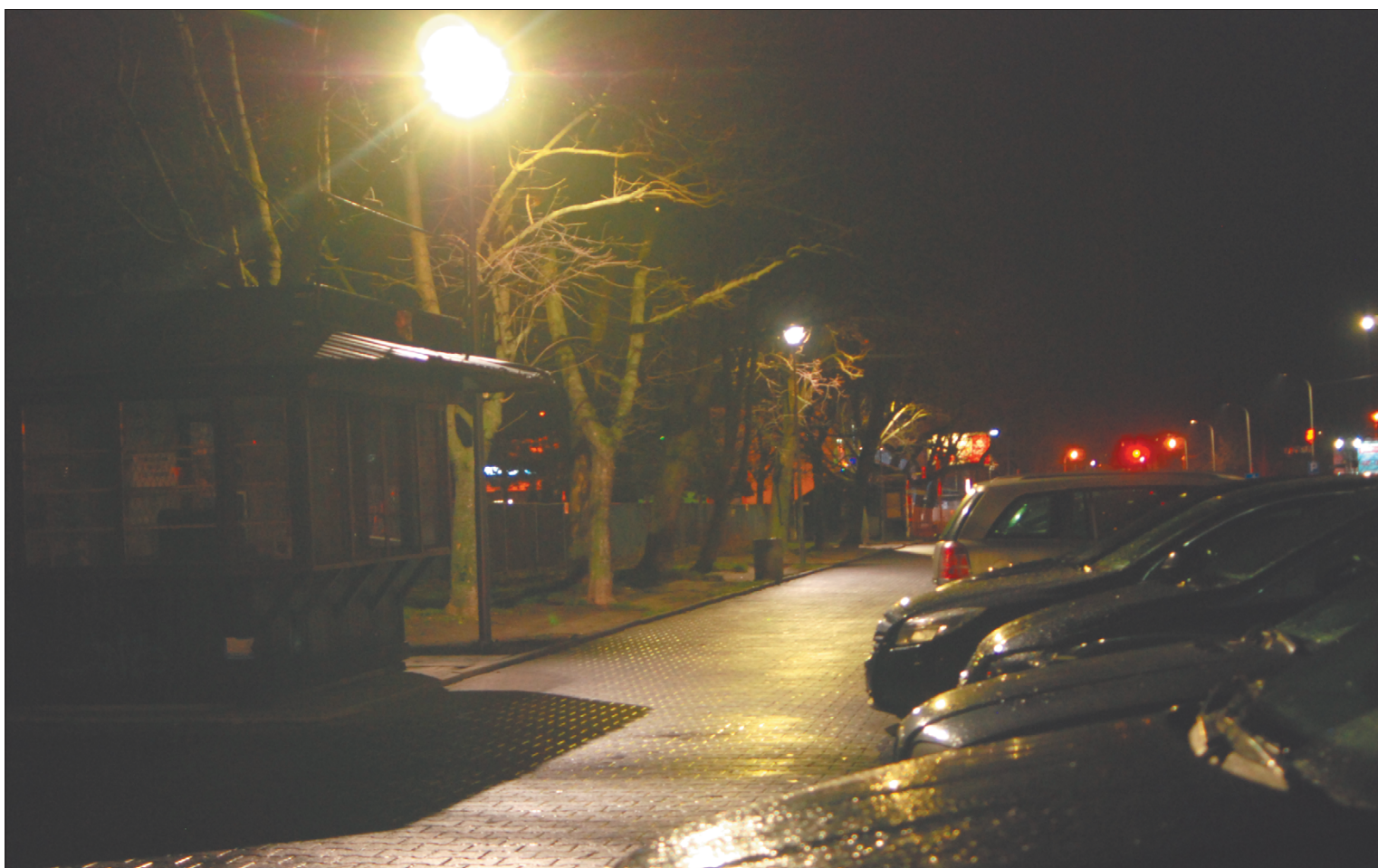
Oświetlenie chodnika przy ul. Obrońców Krzyża.
