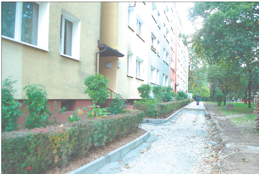
Trwa remont chodnika przy bloku nr 27, os. Jagiellońskie. Fot. Zygmunt Bińczycki
